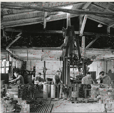
Hall de production Ettlingen env. 1938
