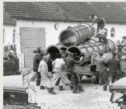
En 1940, le chargement sur un camion de moules pour tubes en béton demandait encore beaucoup d'efforts manuels
